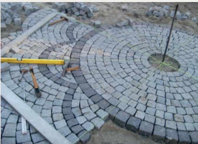
Kleinsteinpflaster während des Verlegens
